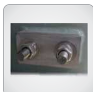
Bornes de puesta a tierra
